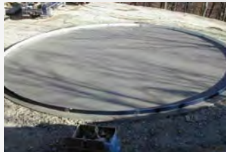
Pour and Complete Concrete Floor Slab
